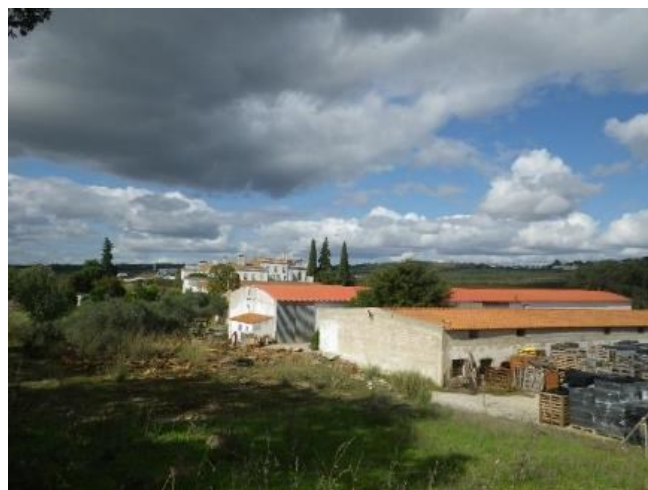
Figura de Anexo 25 – Vista geral do Pavilhão 3, a partir de Este
