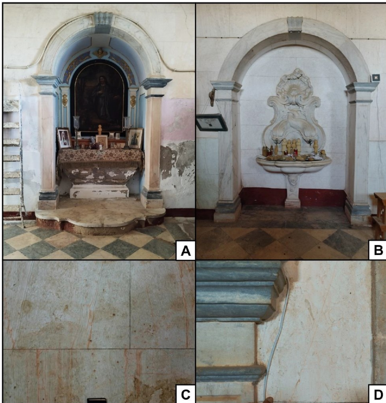
Figura 49 - Mármore utilizados no Edifício A (Convento da Luz), nomeadamente na sacristia que dá acesso à Igreja. Destaca-se o altar (A) e a fonte em mármore de tonalidades claras (B), ambas com portal de mármore fazendo jogos de cor entre mármore claros e escuros, tal como ocorre no pavimento. Destaca-se ainda a aplicação da técnica de marmoreado nas paredes, pretendendo representar os mármore bandados de cores verdes (C) e o Lioz (D), ambos matérias-primas pétreas não locais.
