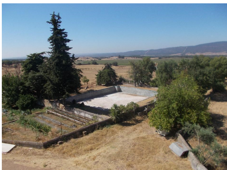
Figura 64 - Aspeto do tanque existente.
