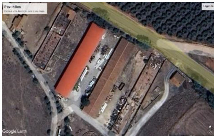
Figura de Anexo 21– Vista geral (Google Earth) dos pavilhões agrícolas
