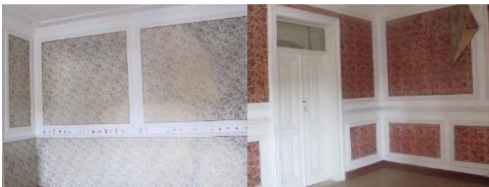
Figura de Anexo 13– Exemplos de divisões no piso superior do convento, com papel de parede
