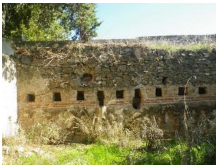
Figura de Anexo 29– Vista da Conduta de Água – lado Este
