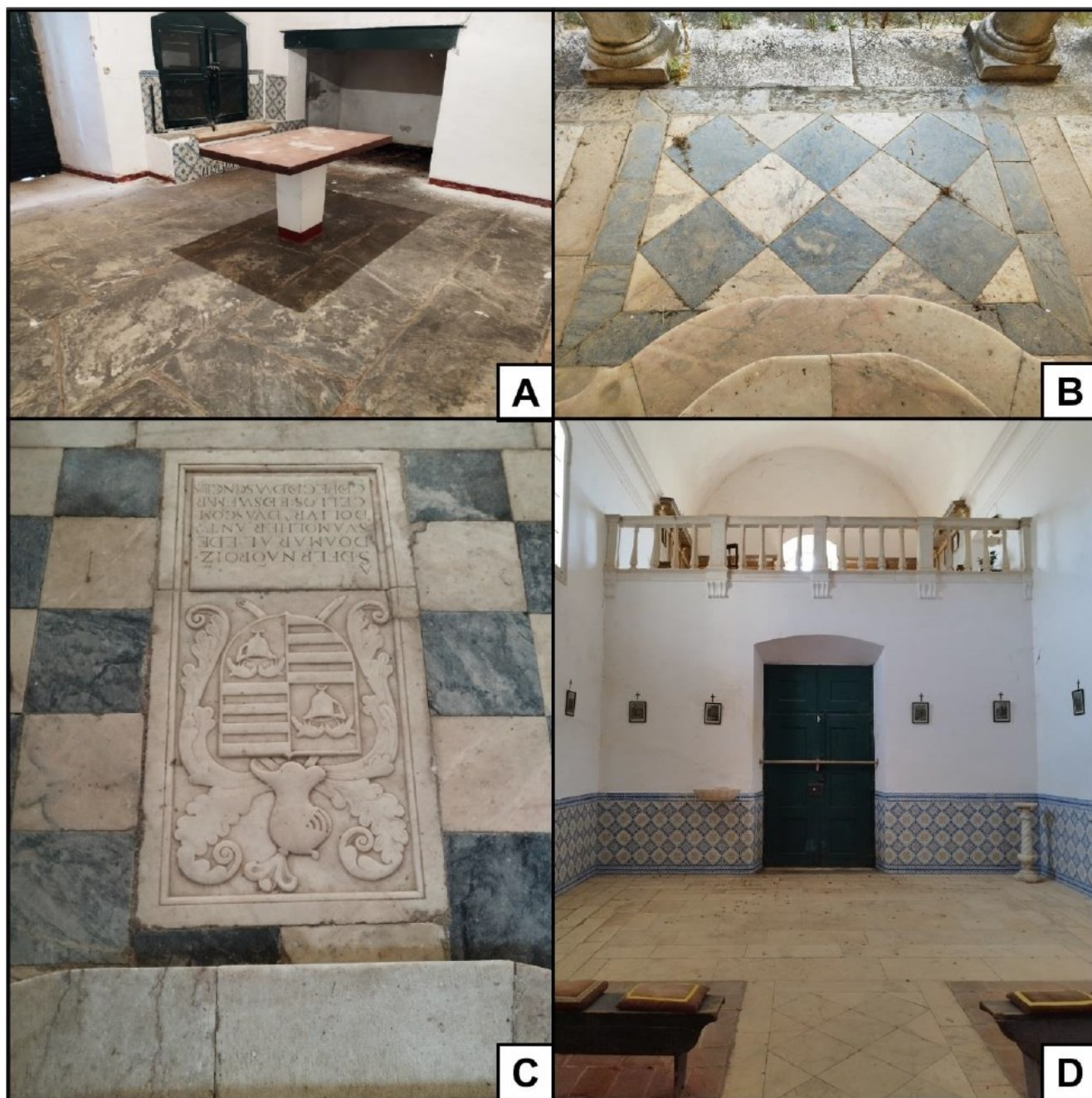
Figura 51 - Material Pétreo utilizado nos pavimentos do Edifício A (Convento da Luz) destacando-se a presença de material xistento na cozinha (A), e de mármore nos restantes espaços, destacando-se os padrões em xadrez no claustro inferior (B) na sacristia e no altar da Igreja (C). Na entrada e corredor de acesso ao Altar da Igreja destaca-se pelo uso e mármore de tons claros (D). De referir ainda a presença de lápides funerárias também em mármore de tonalidades claras quer no chão do claustro inferior, quer na Igreja (C).
