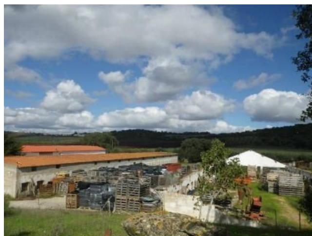
Figura de Anexo 26 – Vista geral do Pavilhão 4
